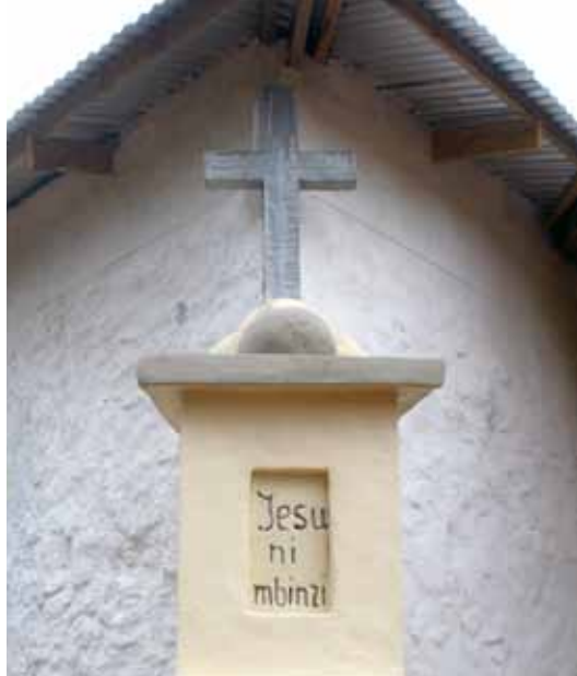
Bei der Restaurierung der Kirche in Kidia wurde auch der sogenannte „Heidenstein“ aufgefrischt, den Bruno Gutmann einbauen ließ.
